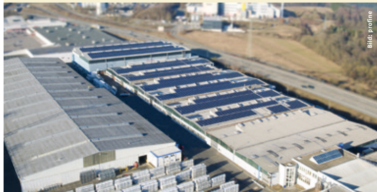
Auf den profine-Werkshallen wurden fast 4.600 Module verbaut.
